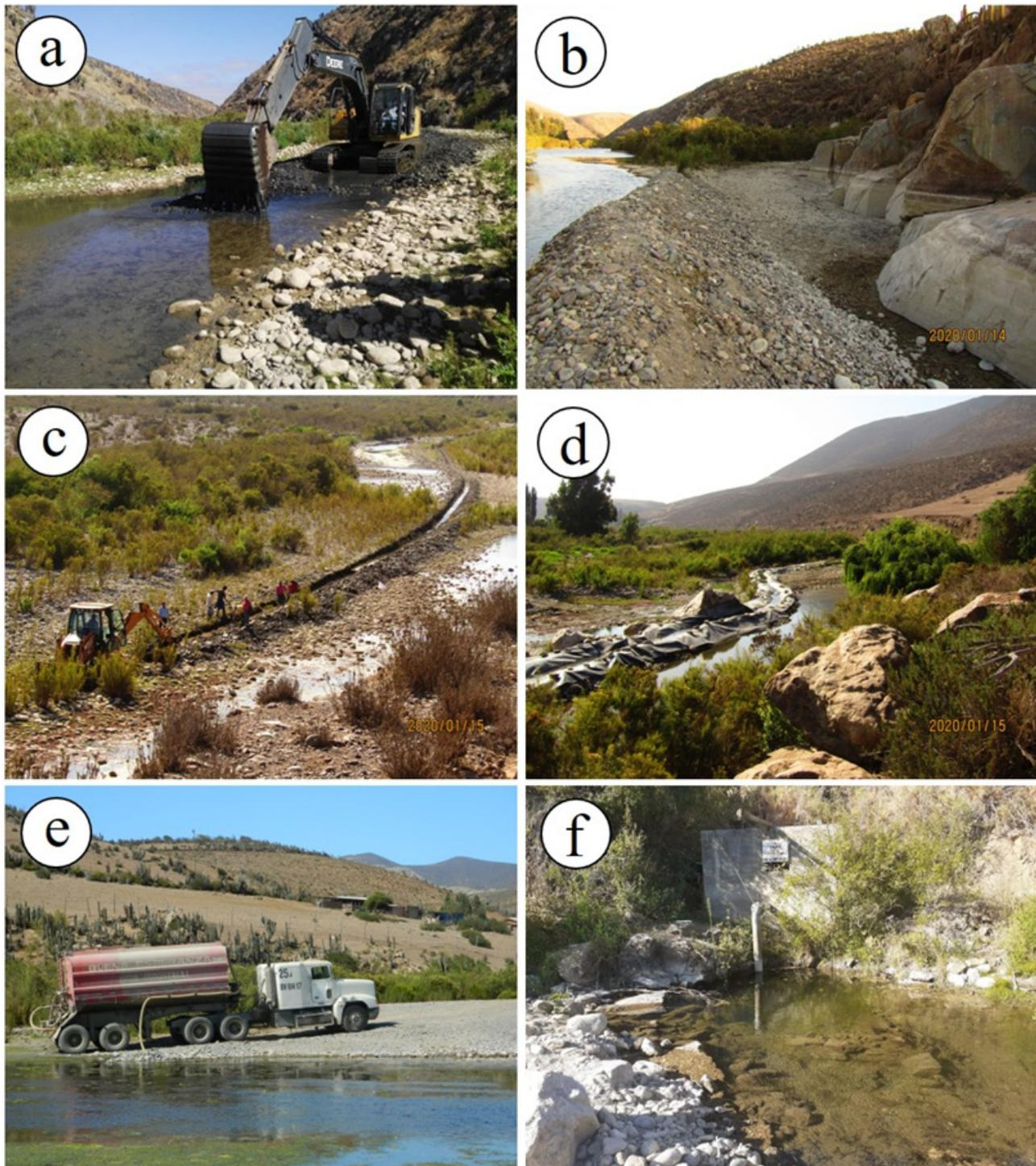
**Figura 29.** Perturbaciones antropogénicas directas sobre el hábitat fluvial de *Cryphiops caementarius* en el río Choapa. (a) canalización de tramo fluvial a través de maquinaria pesada, (b) tramo fluvial canalizado, (c) instalación de geomembranas a través de maquinaria pesada, (d) tramo fluvial con geomembrana instalada, (e) extracción de agua a través de camión aljibe (f) bomba extracción de agua para riego de cultivo de paltos.
